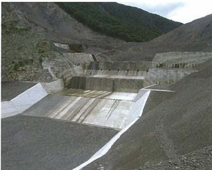
Akatani Sabo Dam (Wakayama)
