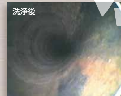
洗浄後 ほぼ元の管径に回復している
