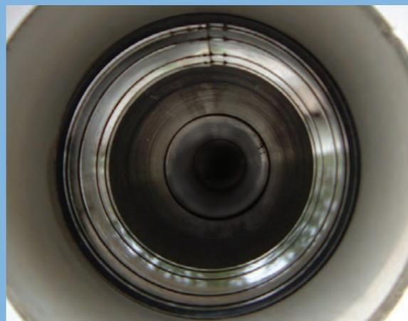
スナップロック工法S 事例:φ250mm
