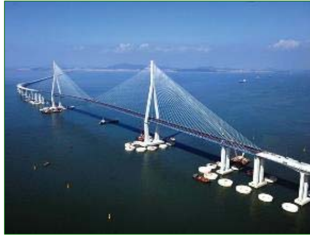
Incheon Bridge, S. Korea
