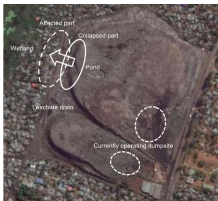
ウレネ処分場の全景
