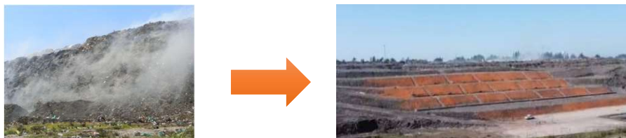
モザンビーク最終処分場における福岡方式による改善事例
