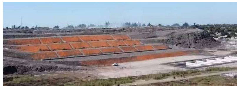
工事完了（全景）（2020年8月）
