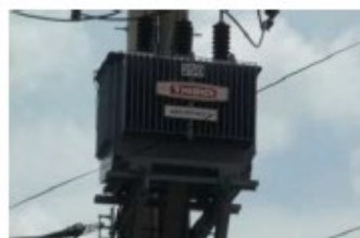
高効率電力変圧器 (裕幸計装) アルファ金属: 日立金属製
