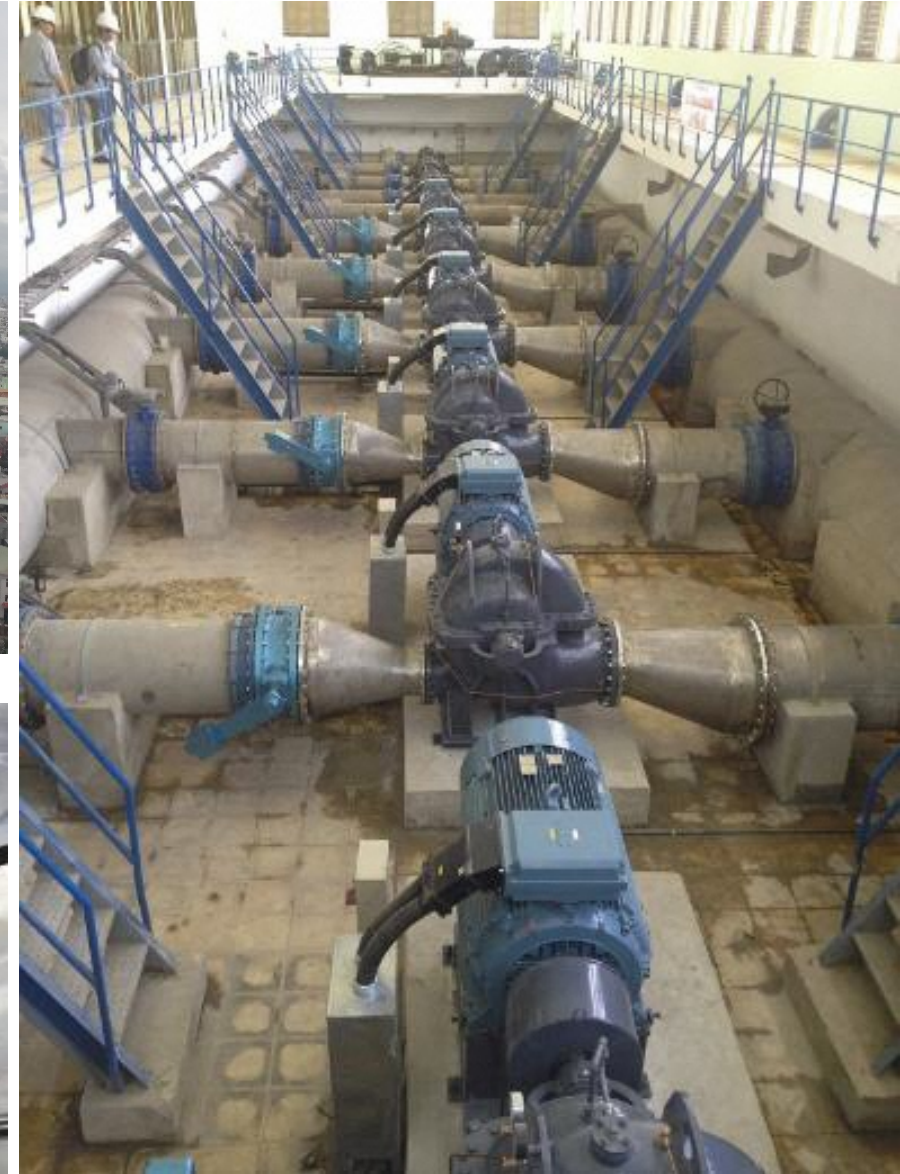
JCM設備補助（水道公社への高効率ポンプ導入）
