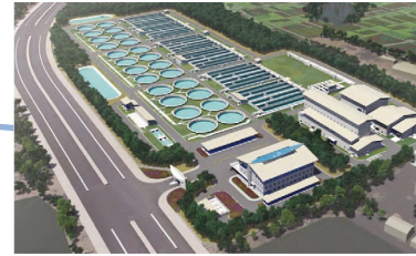
Nhà máy xử lý nước thải Yên Xá
