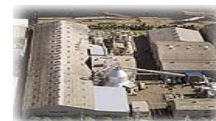
Nhà máy sản xuất bìa
