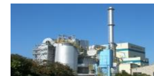
Nhà máy điện sinh khối
