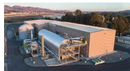
Kompogas® Anaerobic Digestion
