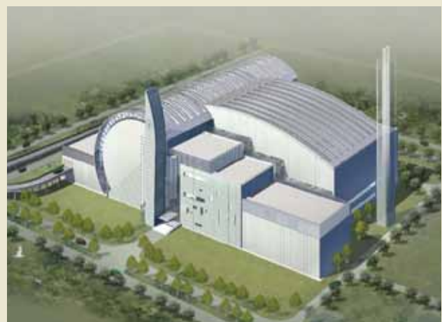
北京には 1,600t/日処理のごみ焼却施設に、30,000KW、蒸気条件 4MPa, 400℃の発電施設が納入されている。 出典：(株)タクマ
