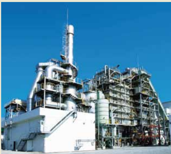
タイでは 2006 年から産業廃棄物の焼却施設が稼働している。処理能力は 1 日 100t/日である。 出典：JFE エンジニアリング(株)
