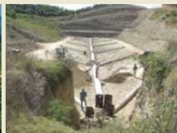
準好気性埋立構造で建設中の処分場
