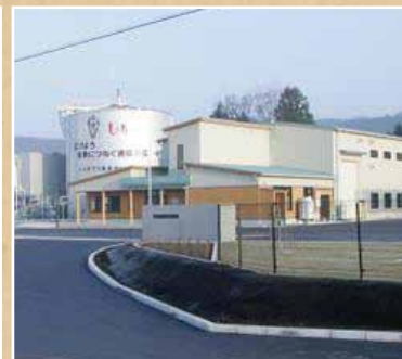
メタン発酵・発電施設
