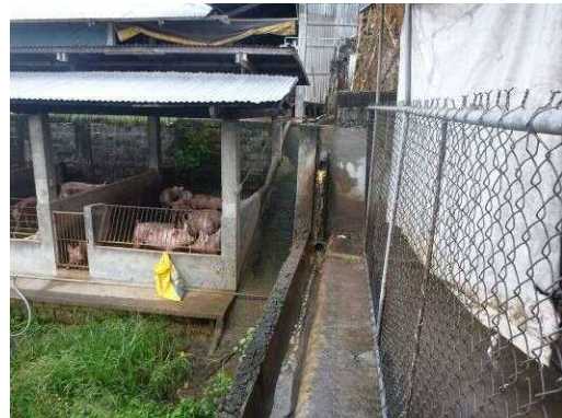
豚舎内排水路状況 (コンクリート製)
