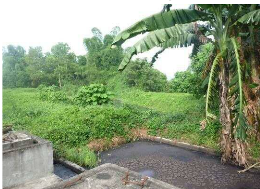
排出汚泥槽 (ここで人力で固形分をすくい取る)
