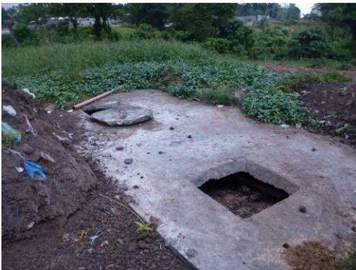
廃水処理タンク
