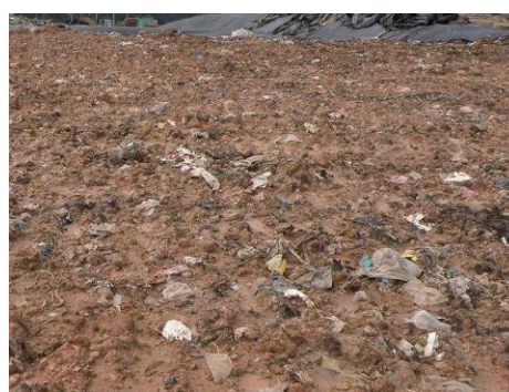
写真2 覆土後の状況(ごみが露出)
