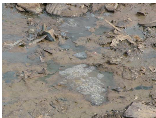
写真4 至る所でガスが湧出している
