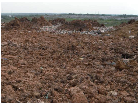
写真1 覆土用材の敷き均し直後の状況
