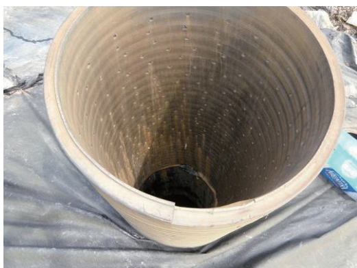
写真3 ガス抜き管の状況(有孔管)
