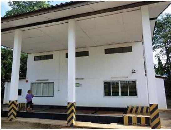
事務棟/トラックスケール
