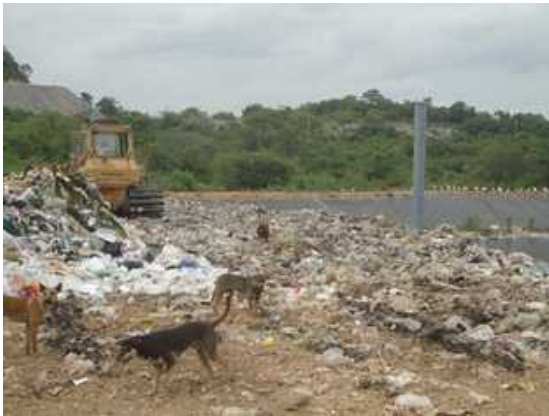
防水シートとガス抜きパイプ
