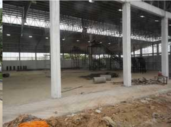
建設中の分別プラント
