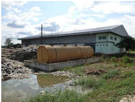
プラスチック油化プラント外景
