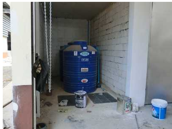
コンポストプラント発酵槽
