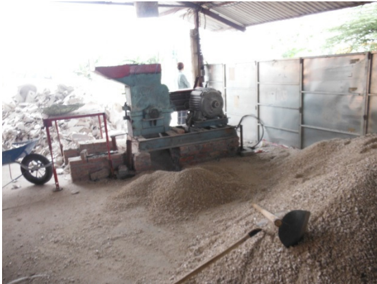
写真 添付①-44. 第一工場全景
