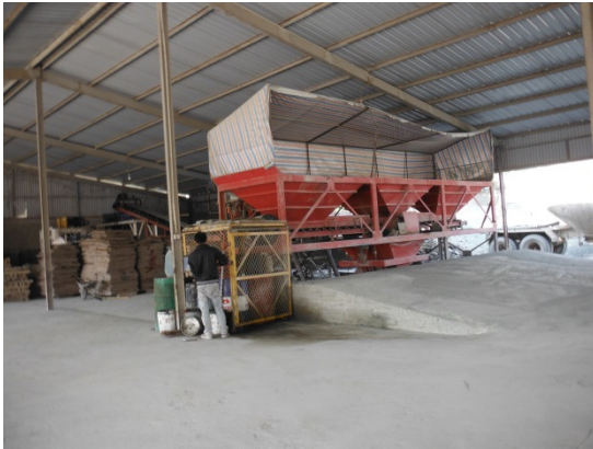
写真 添付①-32.プラント-1
