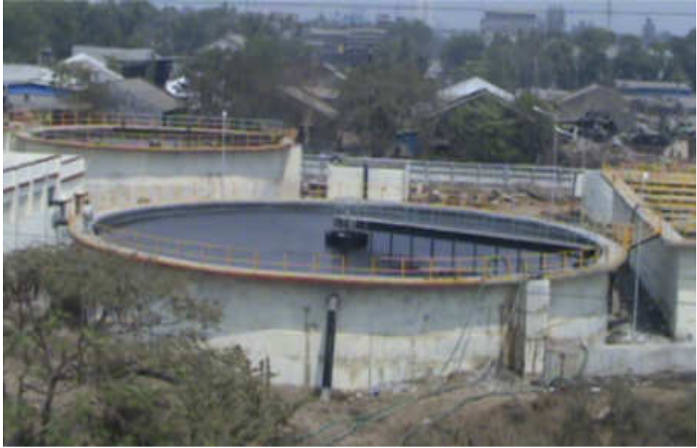
Taloja CETP 1 沈澱池
