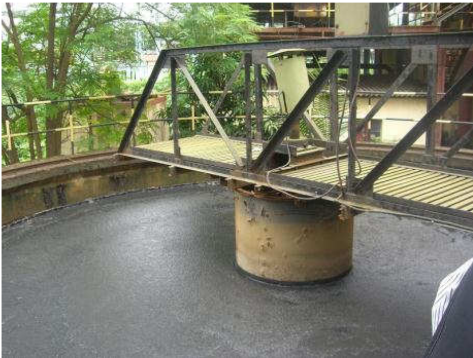
Patalganga CETP 沈澱池
