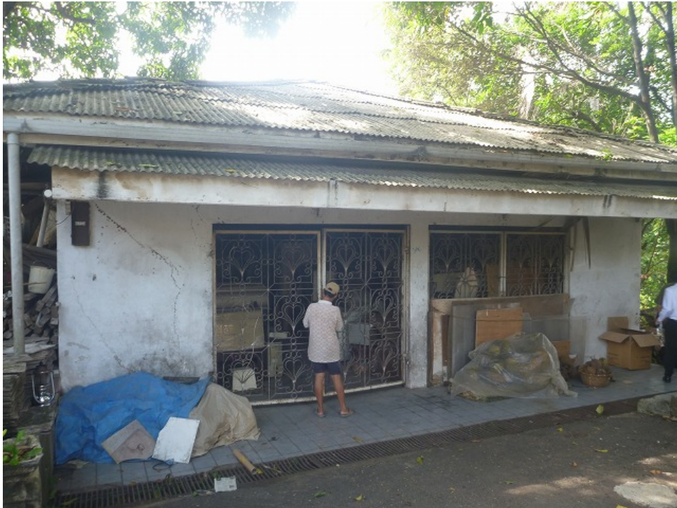
図 3-17 倉庫(今後、塗装費用などを精査)
