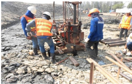
ボーリング機材設置
