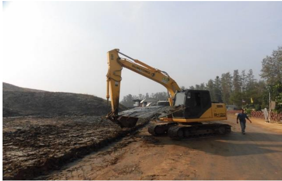
ボーリング地点の表土を掘削
