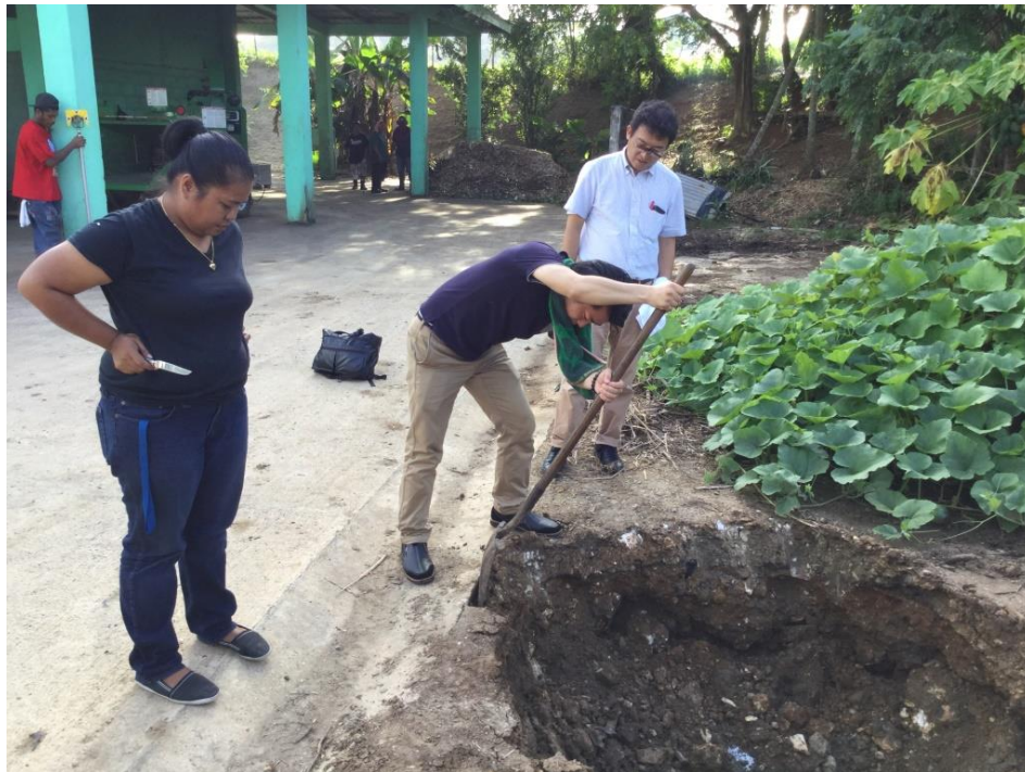
写真 3-1-5 地盤試掘の様子①
