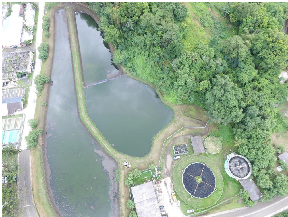
写真 3-1-3 マラカル下水処理場の空撮写真
