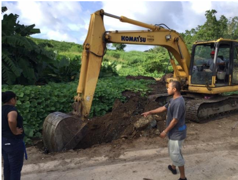
写真 3-2-4 バックホーによる試掘調査
