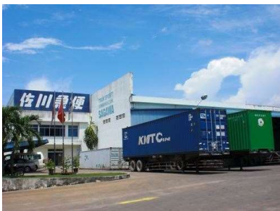
ホーチミン倉庫
