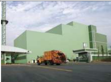
写真 1-3 : Taoyuan 廃棄物焼却施設
