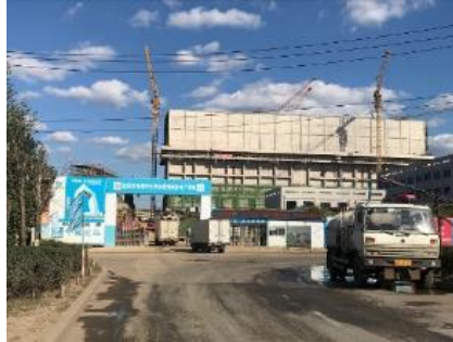
③建設中焼却施設
