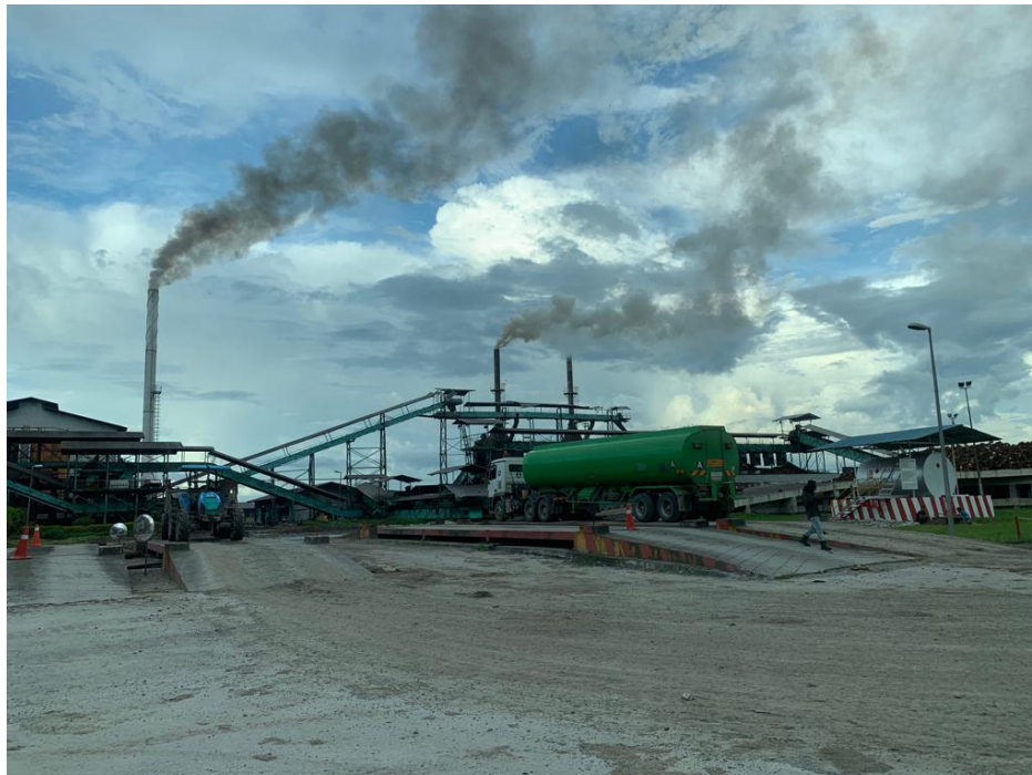
図 3-21 泥炭地域油やし工場・焼却灰製造用焼却炉(右側2本煙突)
