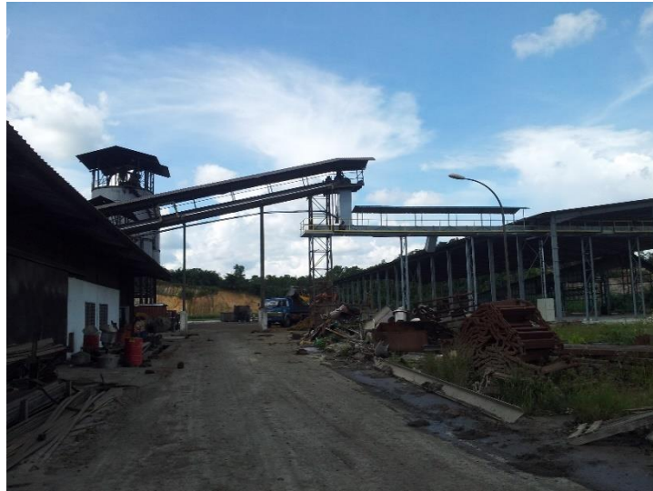
図 3-22 サラワク州テタンガ工場ロングファイバー製造工場（右側）左の油やし工場より EFB がコンベアで送られる
