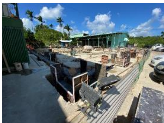
写真 3-3-7 建設中のガラス工房予定地
