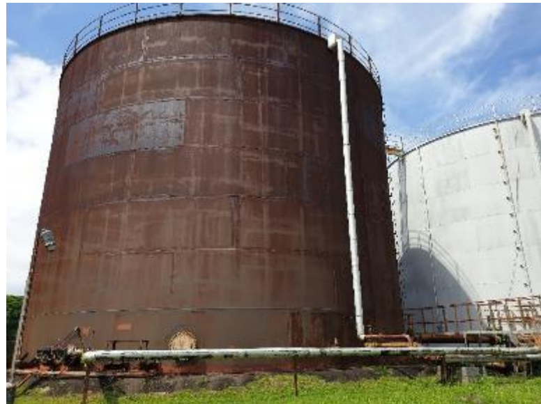
写真 4-8-3 廃潤滑油を保管するタンク
