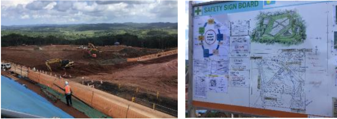
写真 2-2-1 新規最終処分場の建設状況
