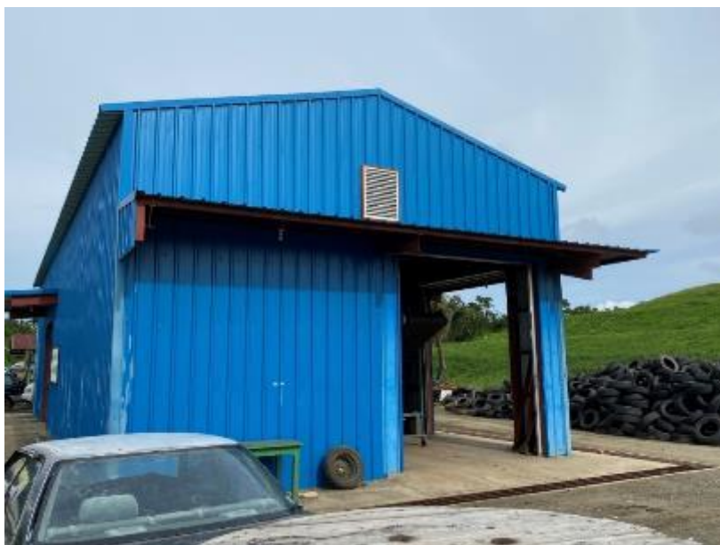
写真 3-6-7 タイヤ破碎設備
