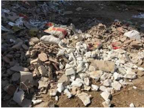
図 1-1 現地建設廃棄物の状態例
