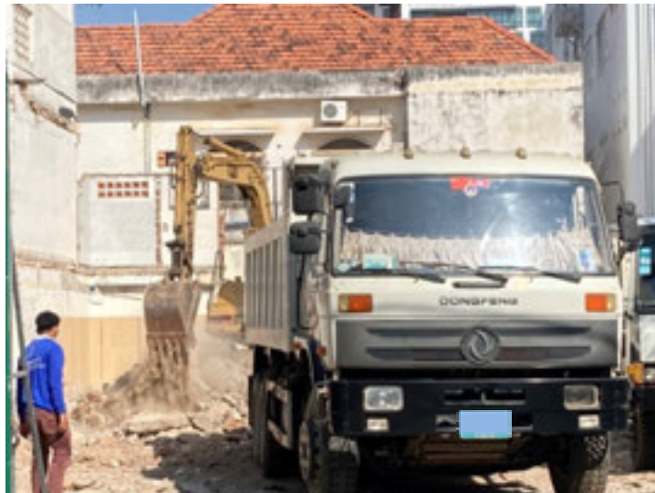
図 3-4-1 建設廃棄物の処理・運搬状況
