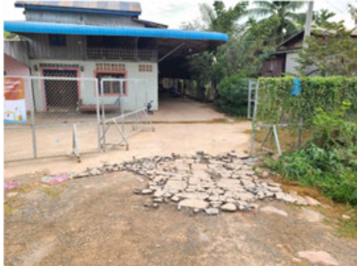
図 3-4-2 アスファルト塊の再利用状況
