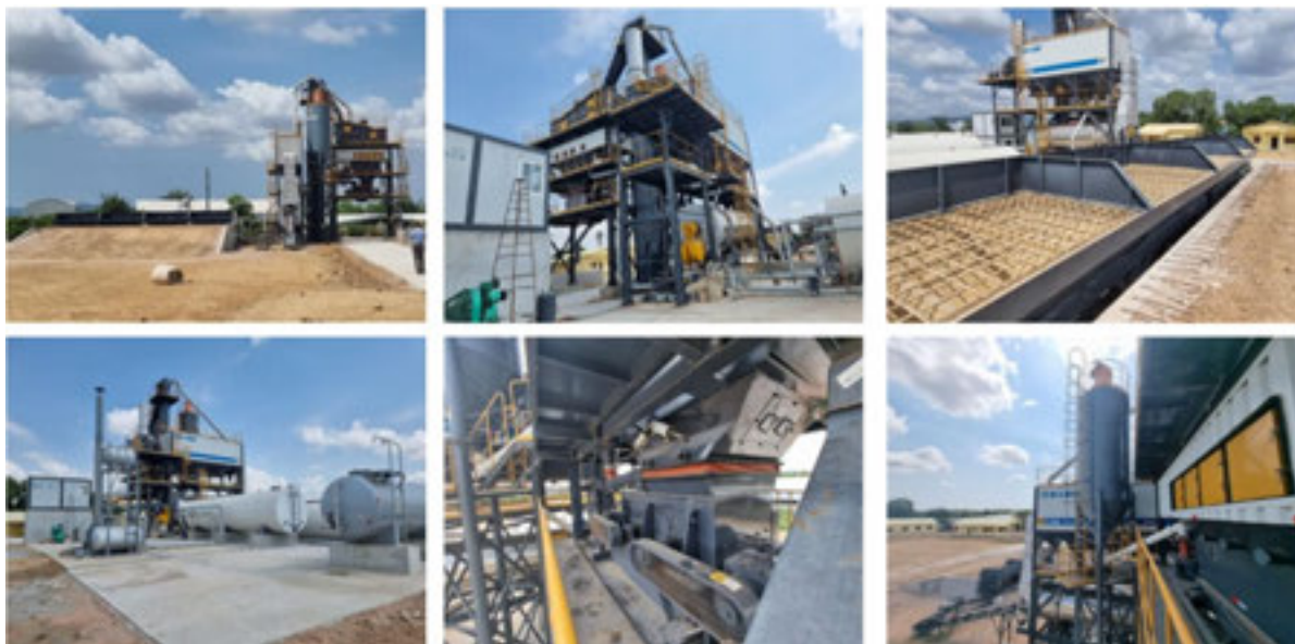
図 5-2-2 カンポット州にある MPWT のアスファルトプラントの状況
