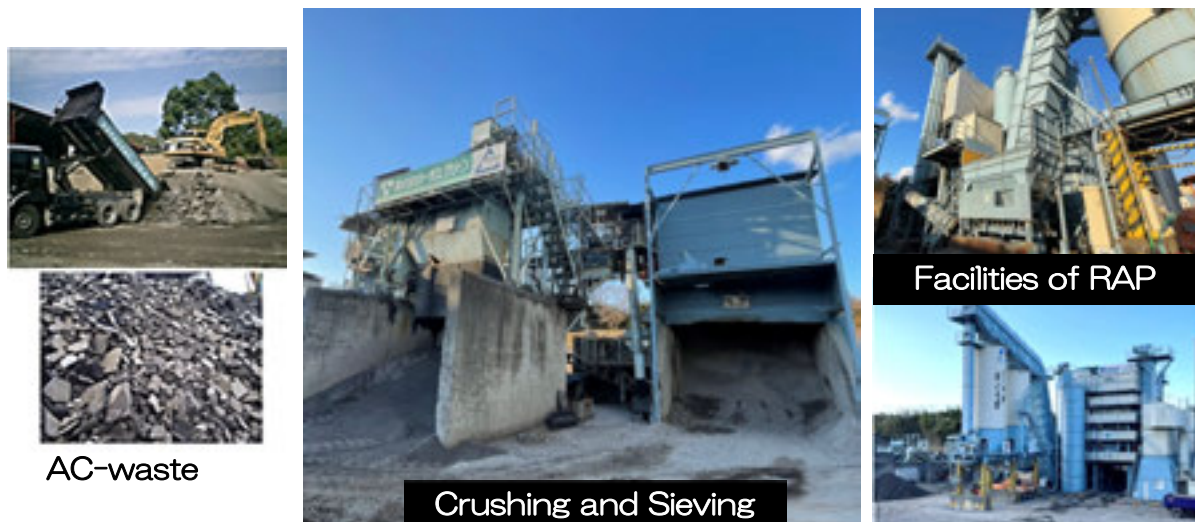
図 2-1 再生骨材プラント（リサイクルプラント）の一例
