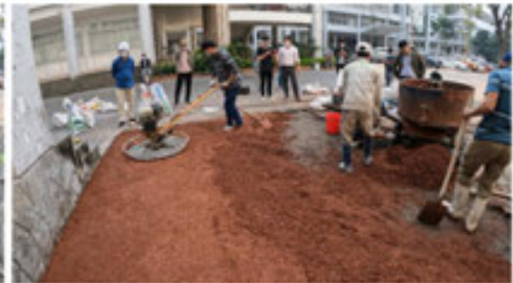
レンガ舗装材施工状況
