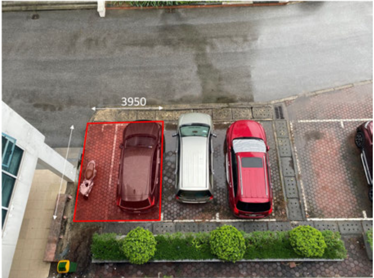
図 5-11 施工場所（駐車場）
