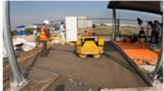
路盤施工状況
