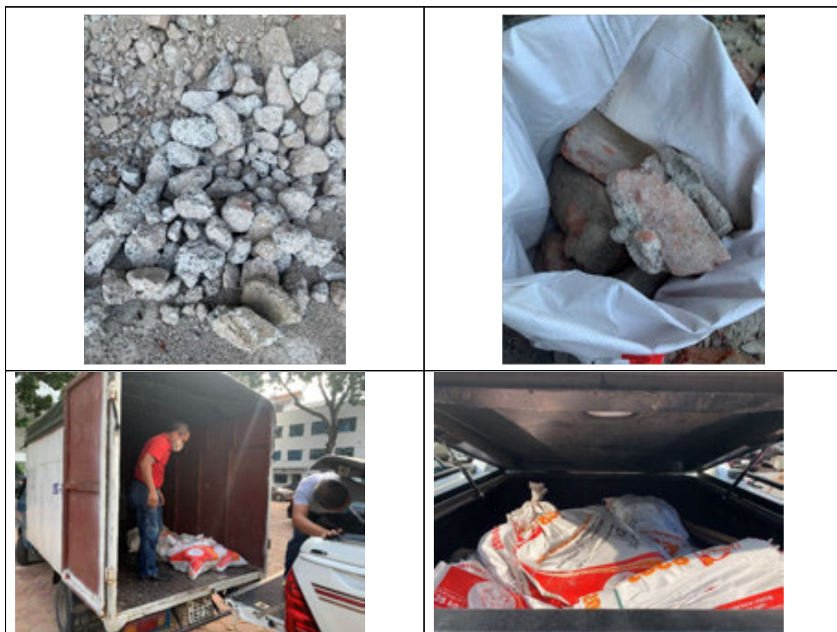
図 4-3 材料（廃レンガ・コンクリートガラ）の現地での調達
