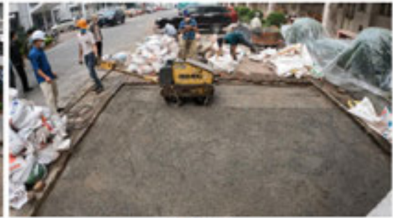
路盤施工状況
