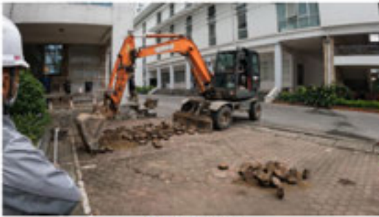
取設舗装面解体状況
