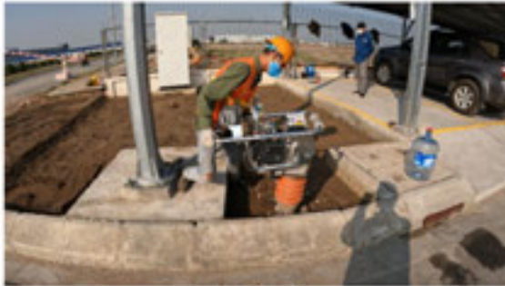
路床転圧状況
