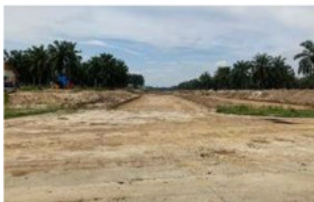
写真 22 整備中の用地
