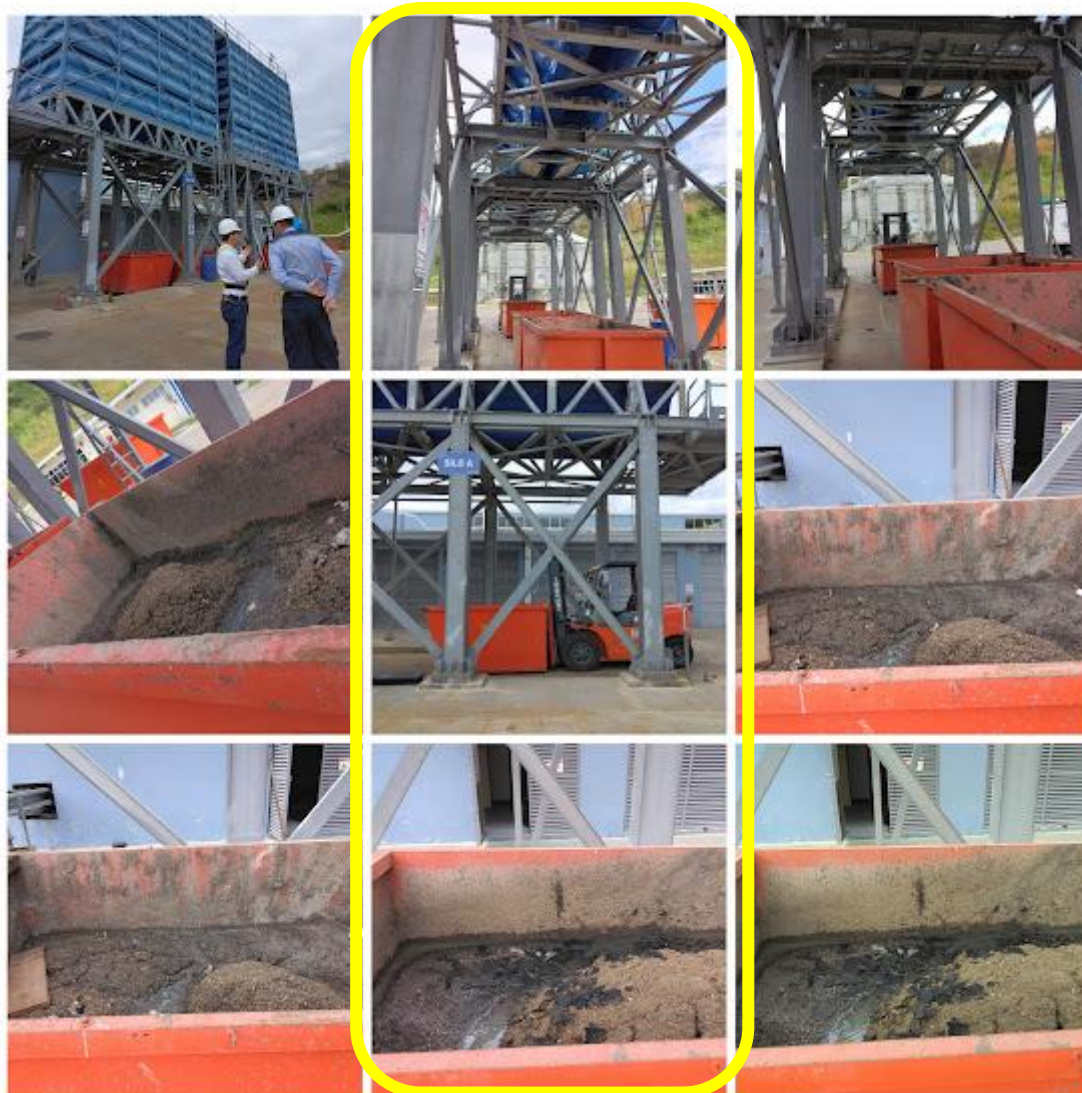
図 2 2 汚泥処理の最終工程の様子
