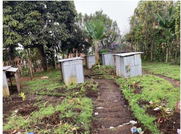
穴の上に設置されたピット式トイレ
