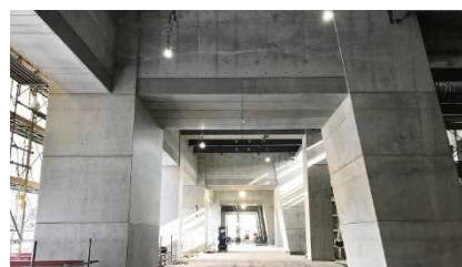
エスコンフィールド HOKKAIDO 大屋根ガーダー架構埋設型枠内部に適用
