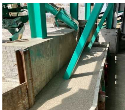
写真 20.4 建屋基礎補強（増し打ち）
