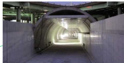
中央環状品川線大井地区トンネル
