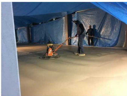
低炭素型のコンクリートの仕上げ状況
