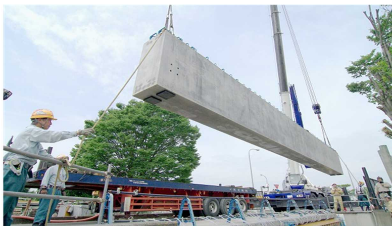
プレストレストコンクリート桁の架設状況
