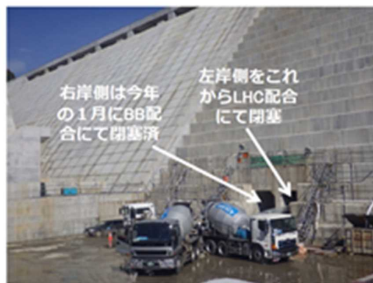
厚幌ダム閉塞工事での打設状況
