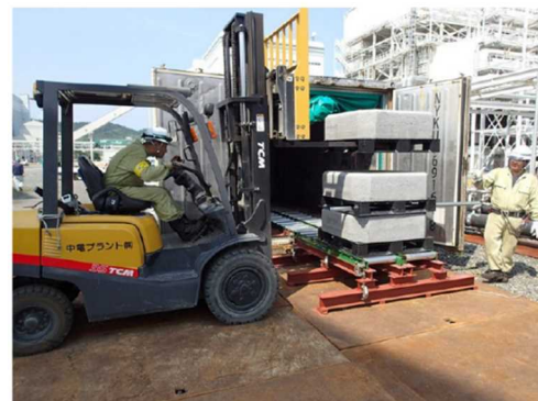
図 1.2 養生槽へのCO 2 -SUICOM製品搬入状況
