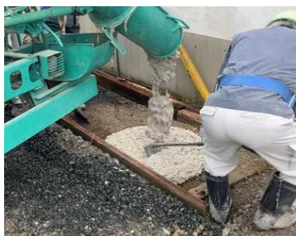
写真 20.5 土間コンクリート
