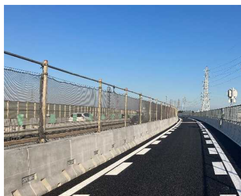
東名阪 弥富高架橋 PCa 仮設防護柵
