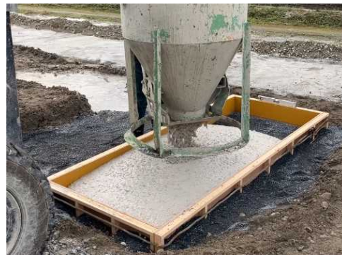
写真 20.2 土間での流動充填性
