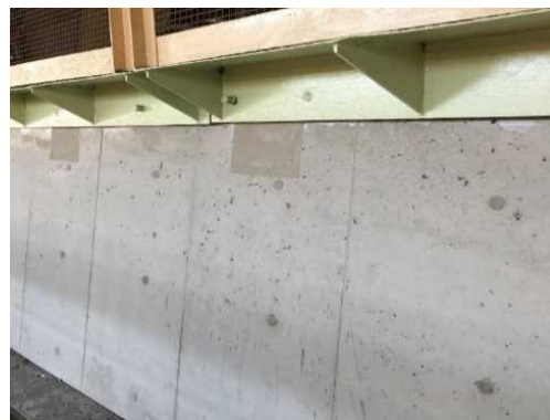
製鉄所内RC擁壁断面補修適用事例
