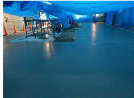
低炭素型のコンクリートの仕上げ完了後の状況
