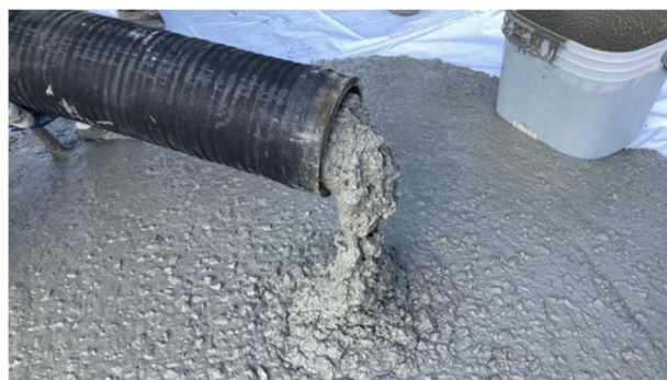
圧送後筒先排出状況
