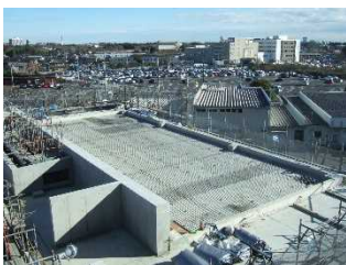
写真 26.1 グリーンオフィス棟
