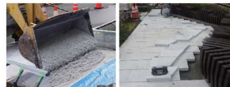
現場打ち舗装施工状況
