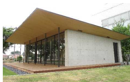
当社技術研究所内施設 クリーンクリート+クリヤ塗料外壁
