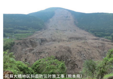
阿蘇大橋地区斜面防災対策工事（熊本県）
