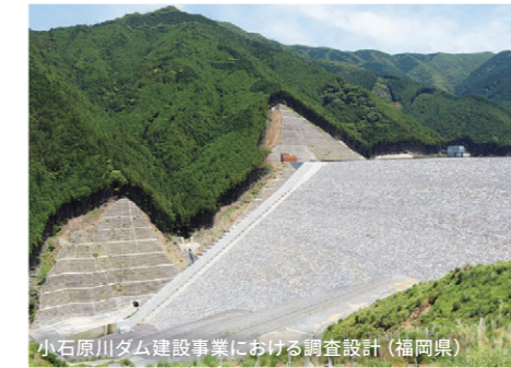
小石原川ダム建設事業における調査設計（福岡県）
