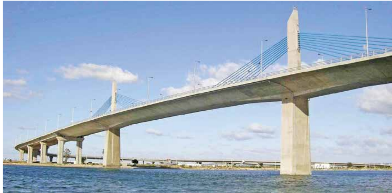
Rades-La Goulette Bridge, Tunisia
