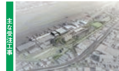
福岡空港国際線ターミナルビル等増改築工事 (福岡県福岡市) 発注者：福岡国際空港(株)
