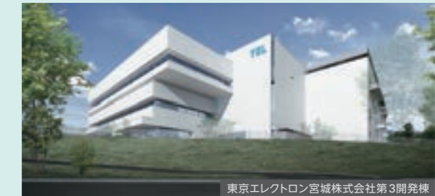
東京エレクトロン宮城株式会社第3開発棟
