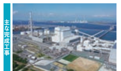
武豊火力発電所5号機 土木建築工事(愛知県知多郡) 発注者：JERA/パワー武豊合同会社
