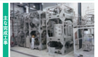
株式会社高砂ケミカル iFactory建設工事(静岡県掛川市) 発注者：(株)高砂ケミカル
