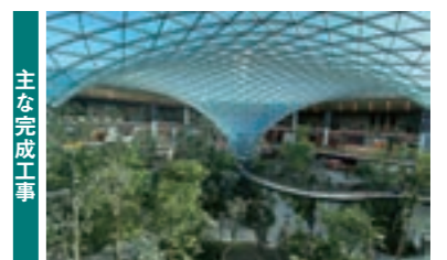
カタール ハマド国際空港旅客ターミナル拡張工事(カタール国) 発注者：カタール空港運営管理会社(MATAR)
