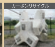
根固めブロック 荒川右岸堤防 国土交通省関東地方整備局
