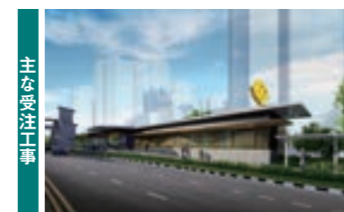
クロスアイランド線-ブンゴル分岐線P103工区(シンガポール共和国) 発注者：シンガポール政府・陸上交通庁(LTA)
