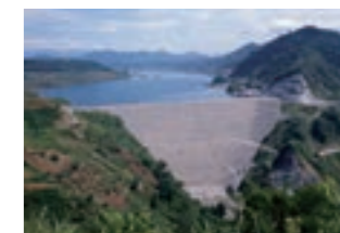
チラタ水力発電所
