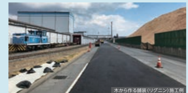
木から作る舗装(リグニン)施工例
