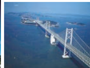
南北備讃瀬戸大橋 (下部工、北工区)
