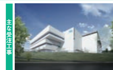
東京エレクトロン宮城株式会社第3開発棟(宮城県黒川郡大和町) 発注者：東京エレクトロン宮城(株)
