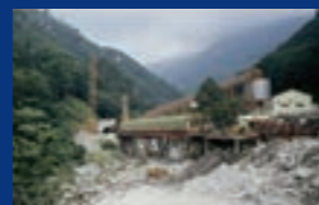
上越新幹線大清水トンネル
