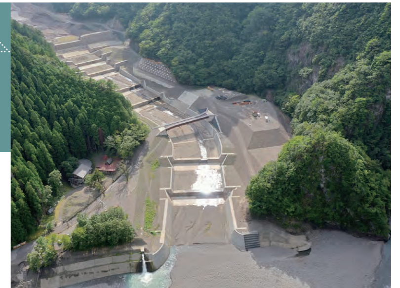
赤谷1号砂防堰堤、溪流保全工(奈良県)
