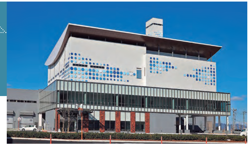
出雲エネルギーセンター（ごみ焼却施設）（島根県）
