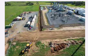
建設中の実証設備
