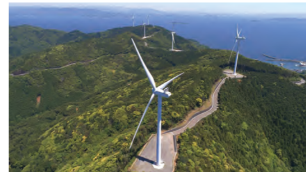
平戸南風力発電所 南サイト(長崎県平戸市)
