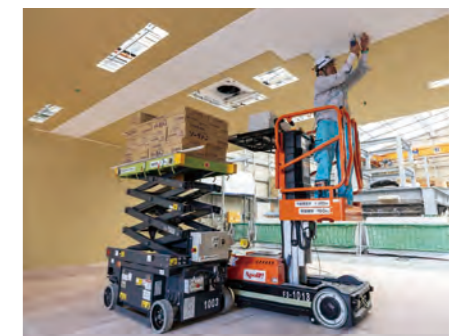
スカイランナー(右)・スカイテーブル(左)を利用した天井仕上げ作業
