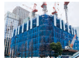
日本橋一丁目中地区 柱前養生(東京都中央区)
