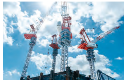
レンタルしている大型タワークレーン
