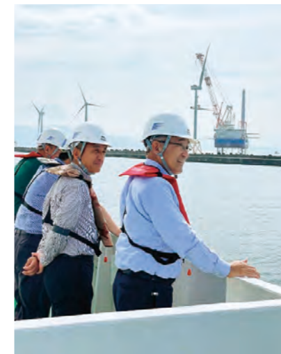
洋上風力発電施設の工事現場を視察
