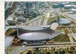
1964 国立屋内総合競技場主体育館 世界に類を見ないワイヤーロープ による吊り屋根構造
