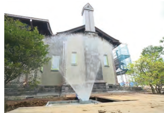
慈雨による建物への放水
