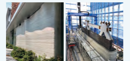
壁の全景 3Dプリンティングの施工
