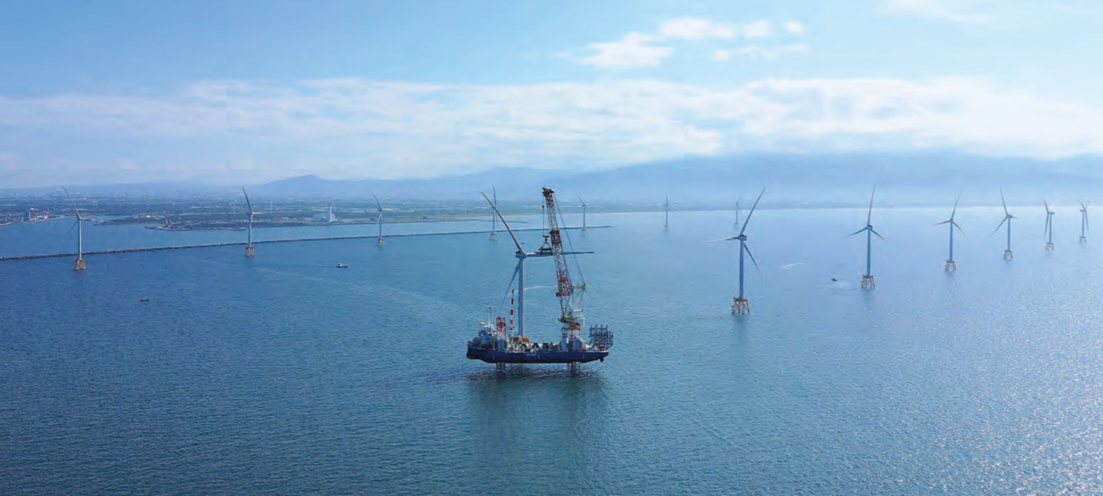
石狩湾新港洋上風力発電所の風車建設(北海道石狩湾新港港内)
