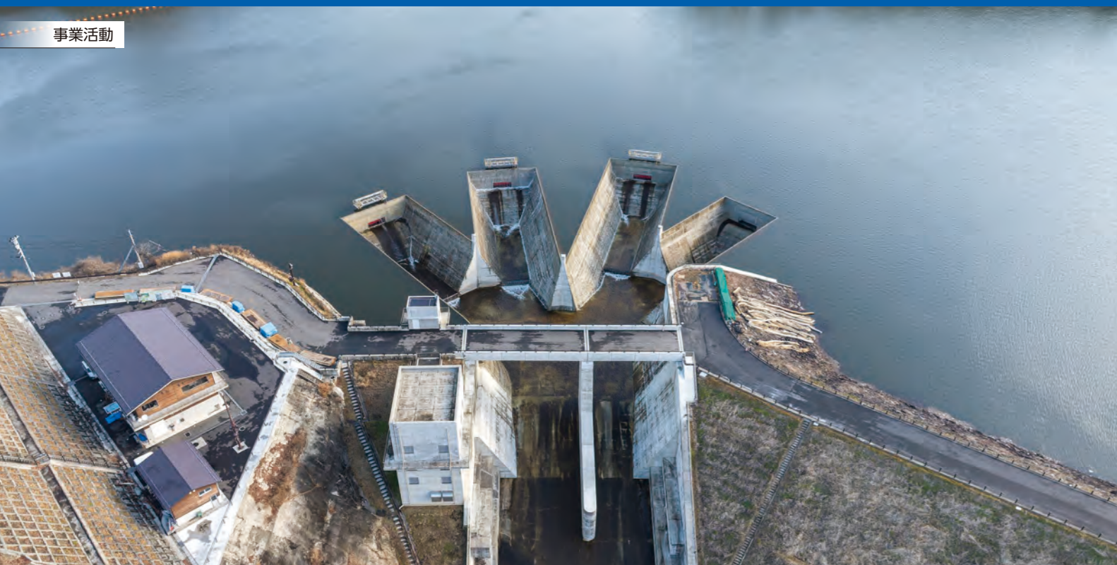
千五沢ダム再開工工事(福島県石川町) ラビリンズ型洪水吐による治水機能付加工工を実施
