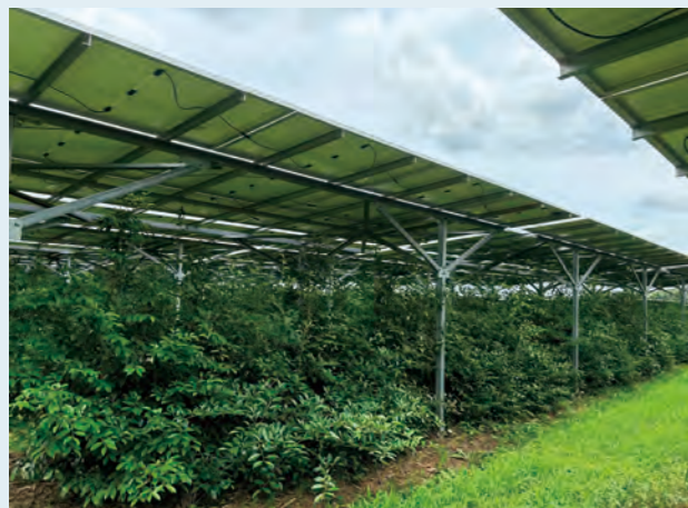
茨城つくば営農型太陽光発電所 (茨城県つくば市)
