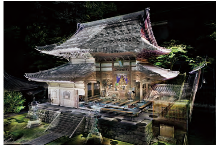
仏殿の点群データ(外観と内部を同時に表示) 永平寺・清水建設共同調査 測量協力T&I 3D
