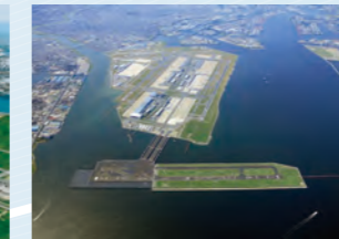
2010 東京国際空港D滑走路 世界でも珍しい理立と構橋のハイ ブリッド構造を採用した大規模海 上滑走路 (画像提供:羽田再拡張D滑走路JV)
