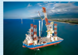
2023 入善洋上風力発電所 当社建造の自航式SEP船「BLUE WIND」で施工
