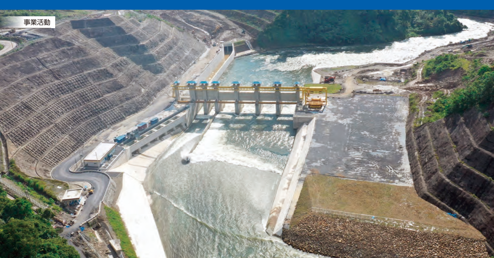
アサハン第3水力発電所 (インドネシア)
