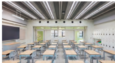
流通経済大学付属柏中学校 (教室内空調・電気設備工事) (千葉県柏市)
