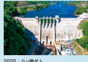
2020 ハツ場ダム 当社初の堤高100m超えの大型ダ ム。プレキャストやICTなどの積極 活用により大幅な工期短縮を実現
