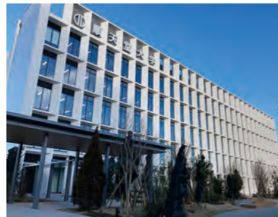
PCaを活用し洗練されたフォルムを持つ順天堂浦安病院 (千葉県浦安市)
