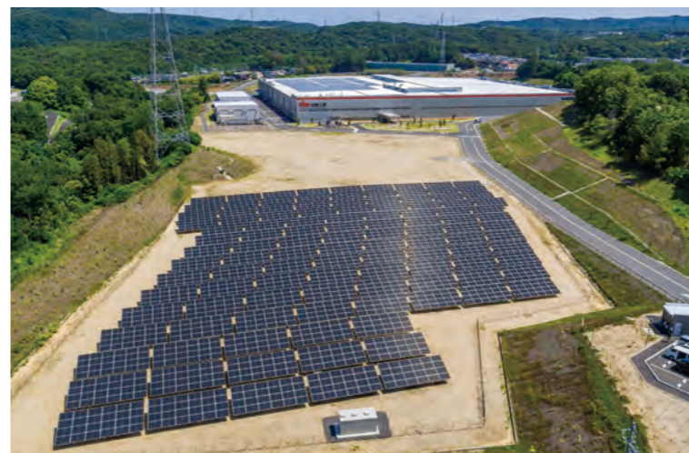
日東工業瀬戸工場 (愛知県瀬戸市)
