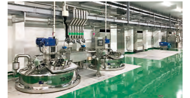
ヤマサ醤油滋賀電王工場 製造タンクおよび自動原料供給設備(滋賀県蒲生郡)
