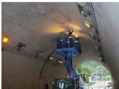
▲トンネル点検
