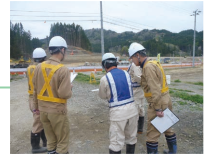
▲事業者との現地確認
