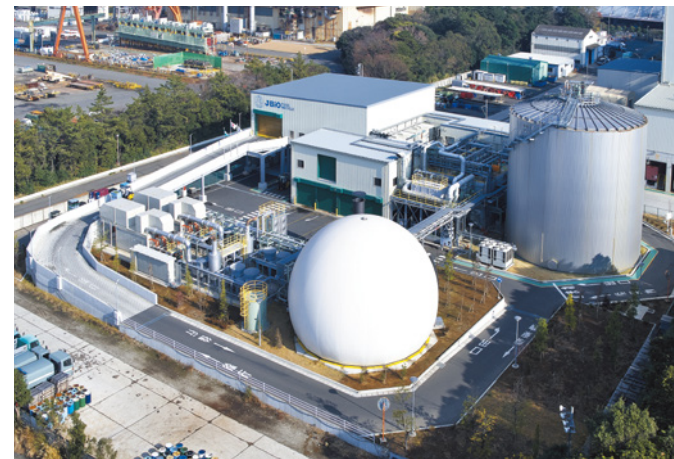
食品廃棄物をバイオガス発電により電気にリサイクルする 神奈川県・(株)Jバイオフードリサイクル 横浜工場
