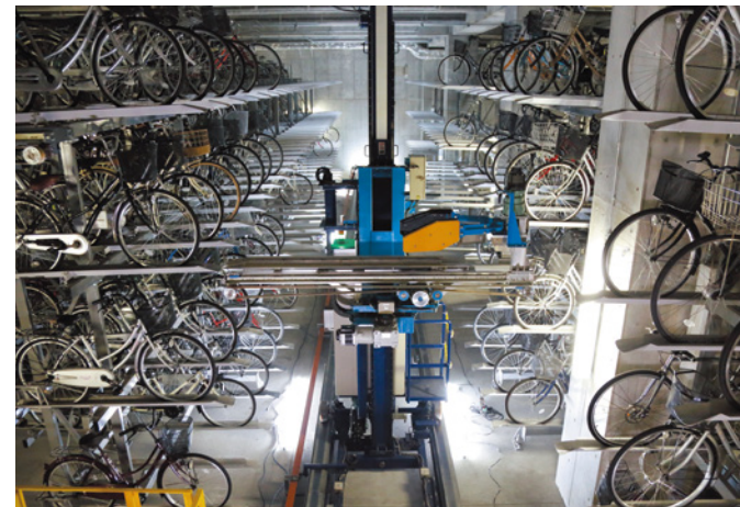
省スペースで、全自動の機械式駐輪場 神奈川県・相模大野駅西側サイクルツリー
