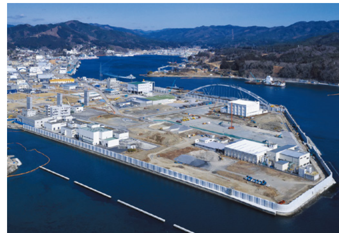
地域の悲願である「安心」に貢献する 宮城県・気仙沼港のハイブリッド防潮堤
