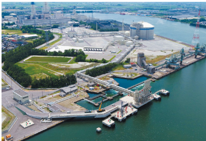
北陸のエネルギー進化を支える 富山県・富山新港LNG基地
