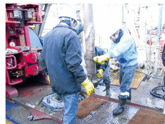
調査井掘削の様子
