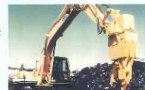
全油圧式マルチ解体機(平成7年ごろ)
