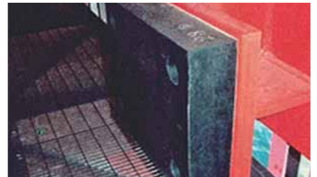
落橋防止システム (PRF緩衝材)
