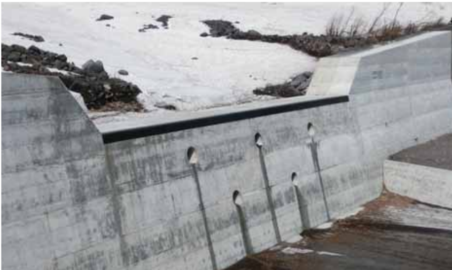
ゴムと鉄板を組み合わせたコンクリート構造物保護材
