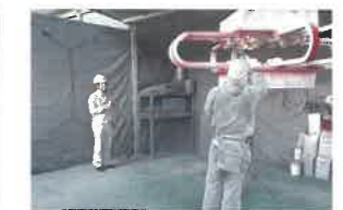
作業環境測定
