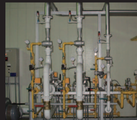
フォアハース燃焼配管ユニット Burning Unit of Forehearth
