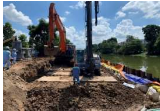
柱状改良工法を採用して、地盤改良を実施している様子
