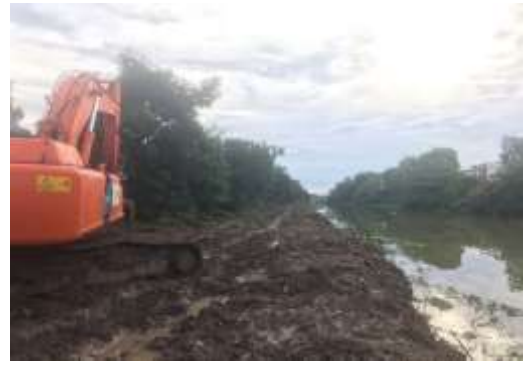
柱状改良工法を採用して、地盤改良を実施している様子
