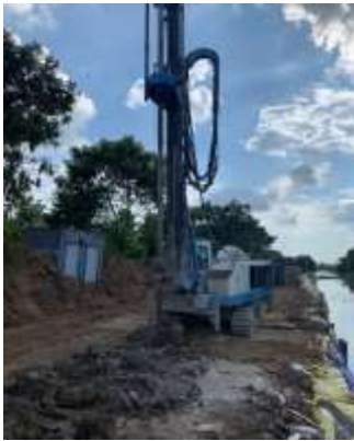
柱状改良工法を採用して、地盤改良を実施している様子
