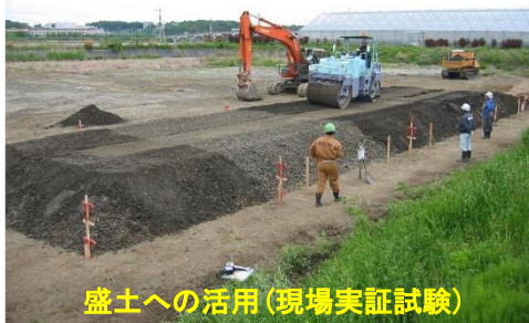
固化材スラリーの前添加状況
