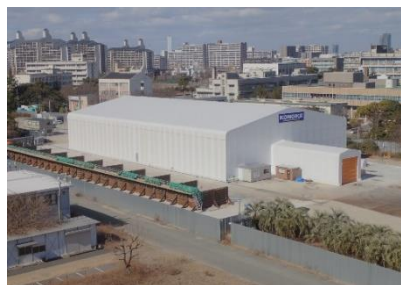
洗浄プラント外観
