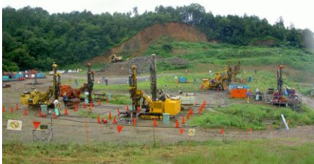
消化対策工事 実施状況
