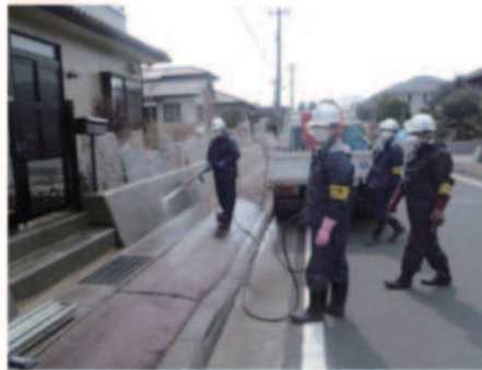
広島町の住宅街での除染作業
