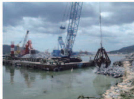
太平洋セメント大船渡工場での、重機船を利用した護岸の復旧
