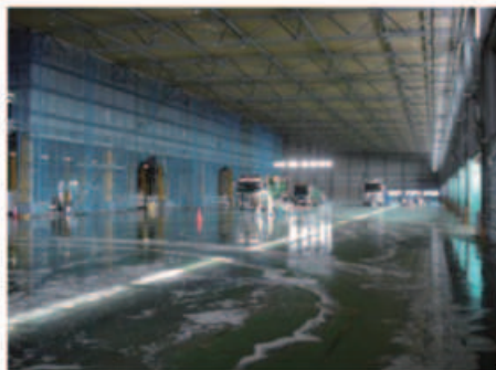
花王仙台ロジスティクスセンターでの、高圧洗浄車によるヘドロの除去
