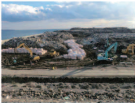
1次仮置き場からの災害廃棄物の移動作業(石巻ブロック)
