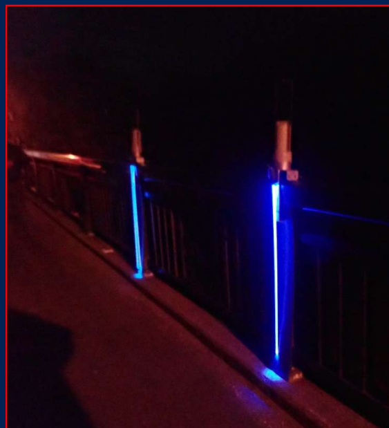
新登別大橋への試験設置
